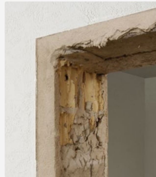
Die Wand nach dem Entfernen der alten Zarge.
