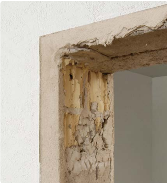
Die Wand nach dem Entfernen der alten Zarge.
