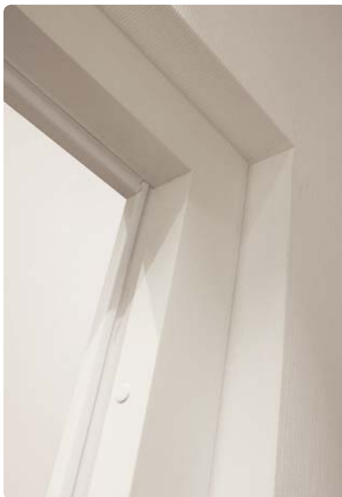
Blendrahmen zwischen den Wänden . (Detail)
