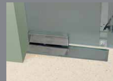
Bodentürschließer mit Eckbeschlag
